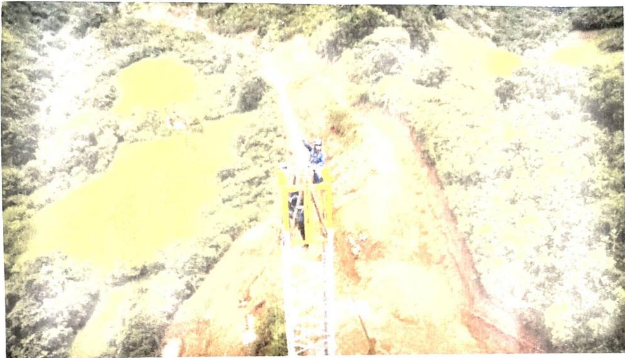
*Montaje de la estructura del teleférico
